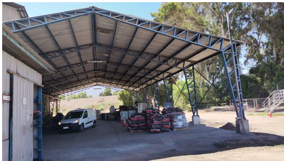
Figura 4: Galpón donde se proyectó instalar Sala de Caldera
